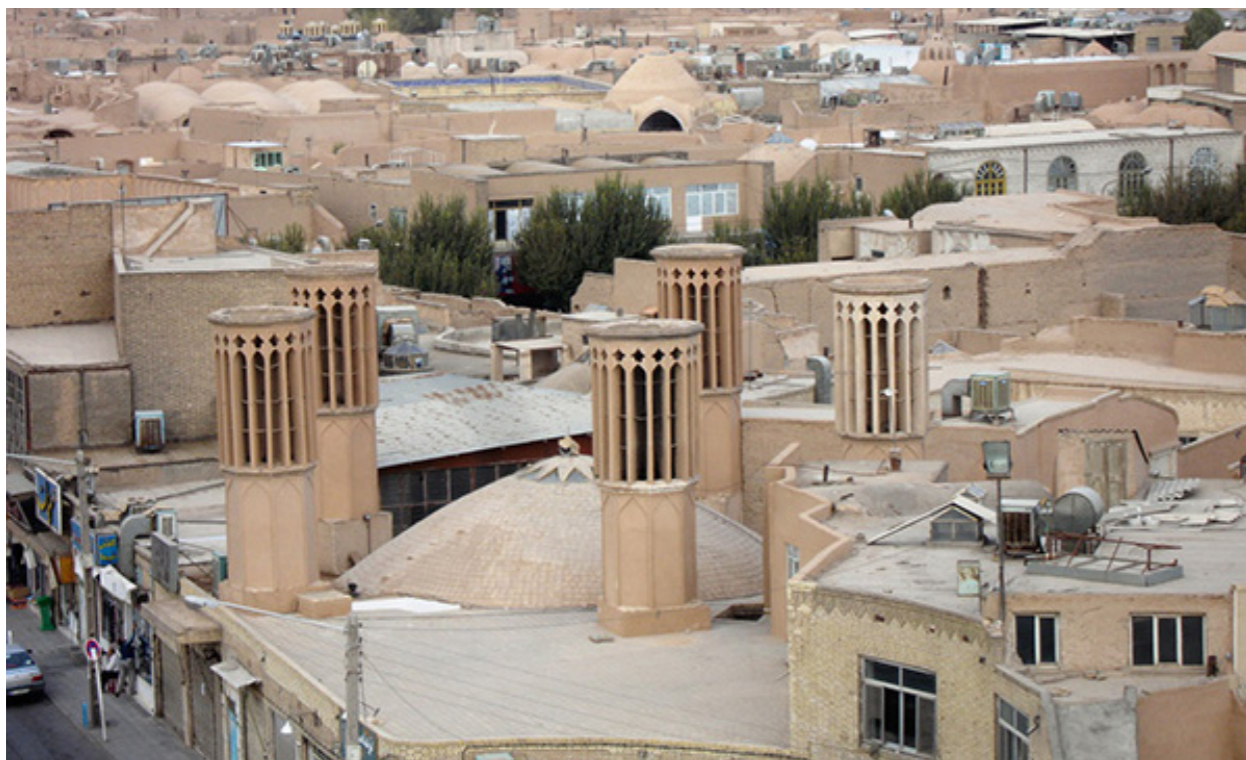
A5.3 - Le "torri del vento" non sono solo una tecnologia intelligente per raffrescare le case in un clima torrido, sono anche elementi caratterizzanti il paesaggio urbano di Yazd, in Iran.
