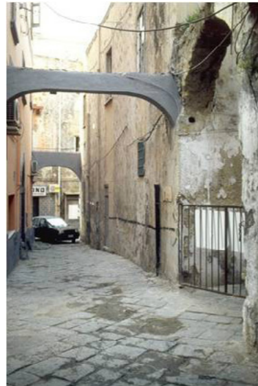
5.4 - Per lungo tempo nei centri storici sono stati autorizzati interventi con tecniche estranee alla tecnologia e alla struttura dell'organismo murario, purché "truccati" da elementi antichi.
